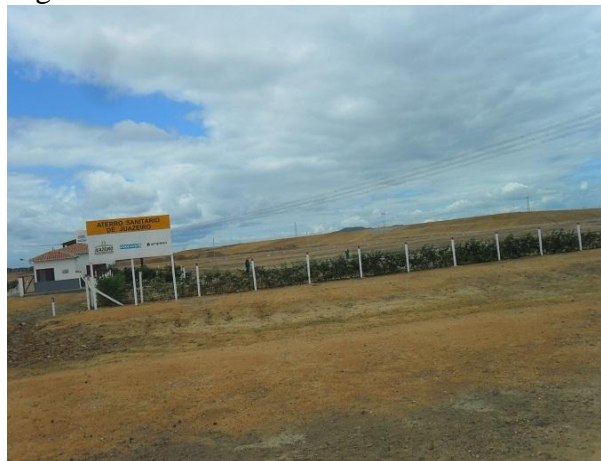
Figura 7: Vista do aterro controlado da cidade.
