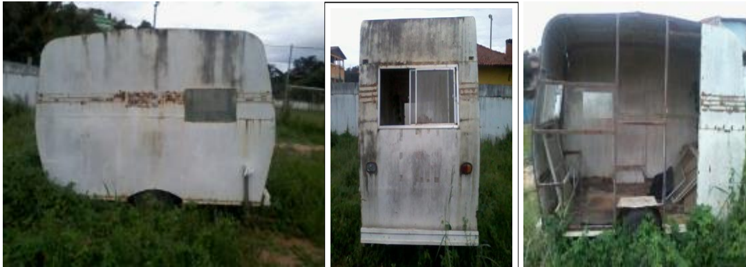
Figura 04. Trailer antes da reforma
