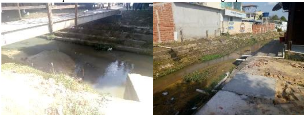
Figura 3 e 4: Ponte que liga a Av. Copacabana à Av. Coronel Mâncio Lima, facilitando o trânsito dos pedestres. Nota-se o assoreamento do leito do igarapé.
