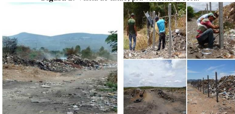
Figura 2: Visita ao lixão, pra vistoriar a obra.
