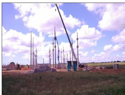
Figura 7 - Instalação da subestação do Parque Eólico FONTE: Elaborado pelos autores (2014)
