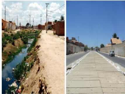
Figura 2 – Canal da Vila Jacaré antes (à esquerda) e depois (à direita) de ser coberto. Fotos: Jean Corrêa, 2003 (esquerda) e Matteo Nigro, 2015 (direita).
