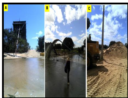
Figura4: (A) Caixa de metal de uma empresa instalada a poucos metros do rio. (B) Tanque improvisado recebendo o material do leito do rio no setor leste. (C) Armazenagem da areia processada e circulação de máquinas pesadas.
