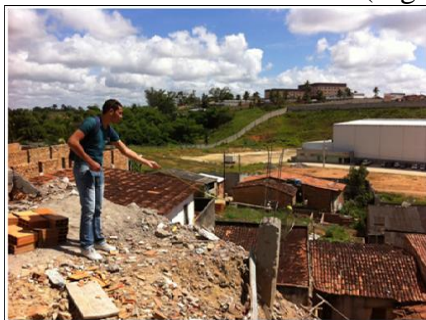
Figura 5: Medição da escora de sustentação que foi insuficiente para obter o peso da construção.
