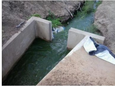
Figura 03: Disposição de água dos viveiros colocados diretamente no Leito Fluvial. Fonte: Barreto, 2014
