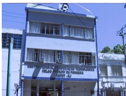
Figura 3: Fachada do CEFET/RJ campus Maracanã Fonte: A pesquisa
