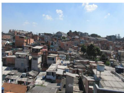
A submoradia do Jardim Nova Cumbica, além de vielas estreitas, apresenta pouca iluminação e ventilação, com casas sobre o córrego e sem coleta de resíduos domiciliar
